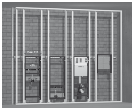
Montage als Vorwand raumhoch
