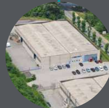
Costruzione nuovo capannone a Gravellona Toce (VB) New headquarter in Gravellona Toce (VB)
